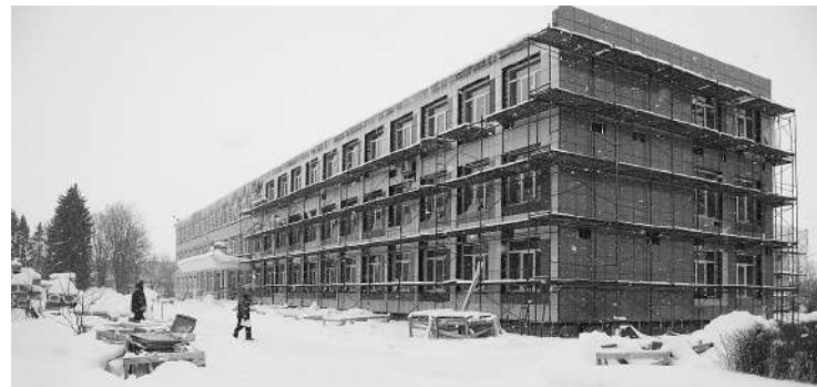
● Ремонт школы в Бегуницах
