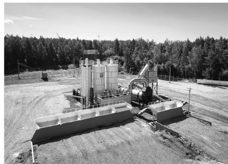
Новый завод выпускает 1200 тон асфальта в смену
