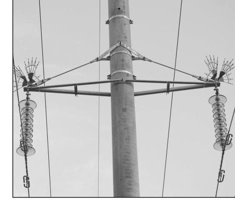
возникновение аварийных ситуаций, после грозовых явлений. Поэтому для сокращения технологических нарушений энергетики оборудуют линии электропередачи специальными устройствами, которые минимизируют риски отключений потребителей и обеспечивают безопасность популяции редких птиц. По форме оборудование напоминает каркас раскрытого зонтика ярко-оранжевого цвета. Яркий элемент отпугивает птиц и вынуждает их искать более безопасные места для отдыха и гнездования.
