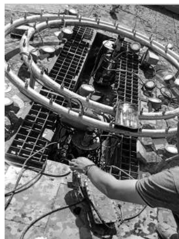
● Ремонт фонтанного комплекса
