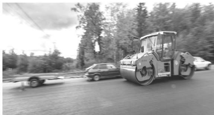
Строительство моста через Свирь идёт с применением технологии литого асфальта
