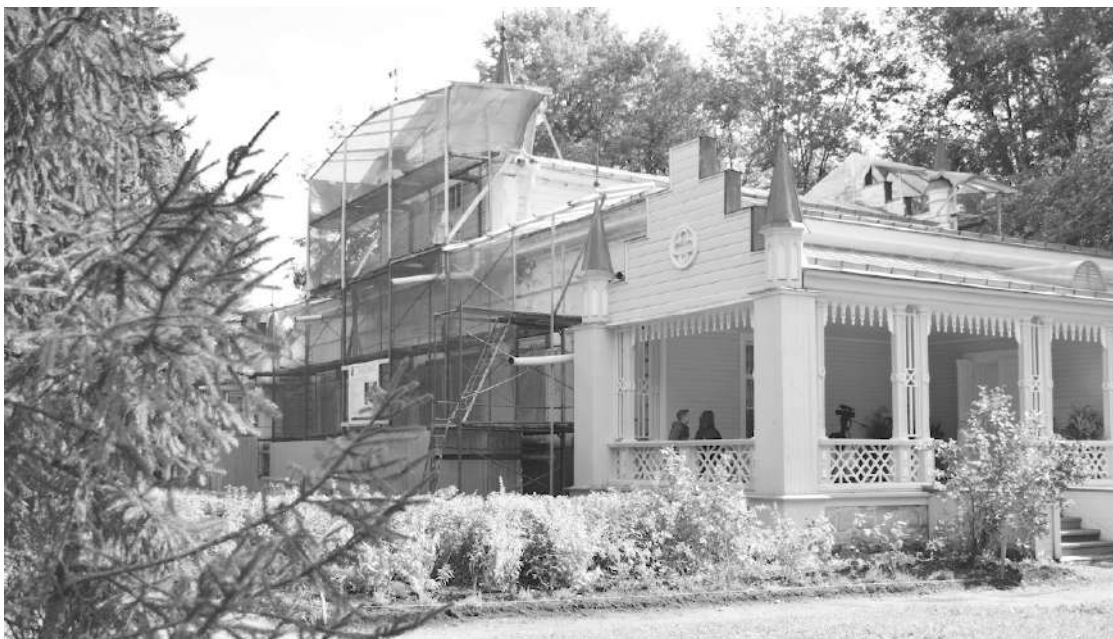
● Ремонт фасада усадебного дома
